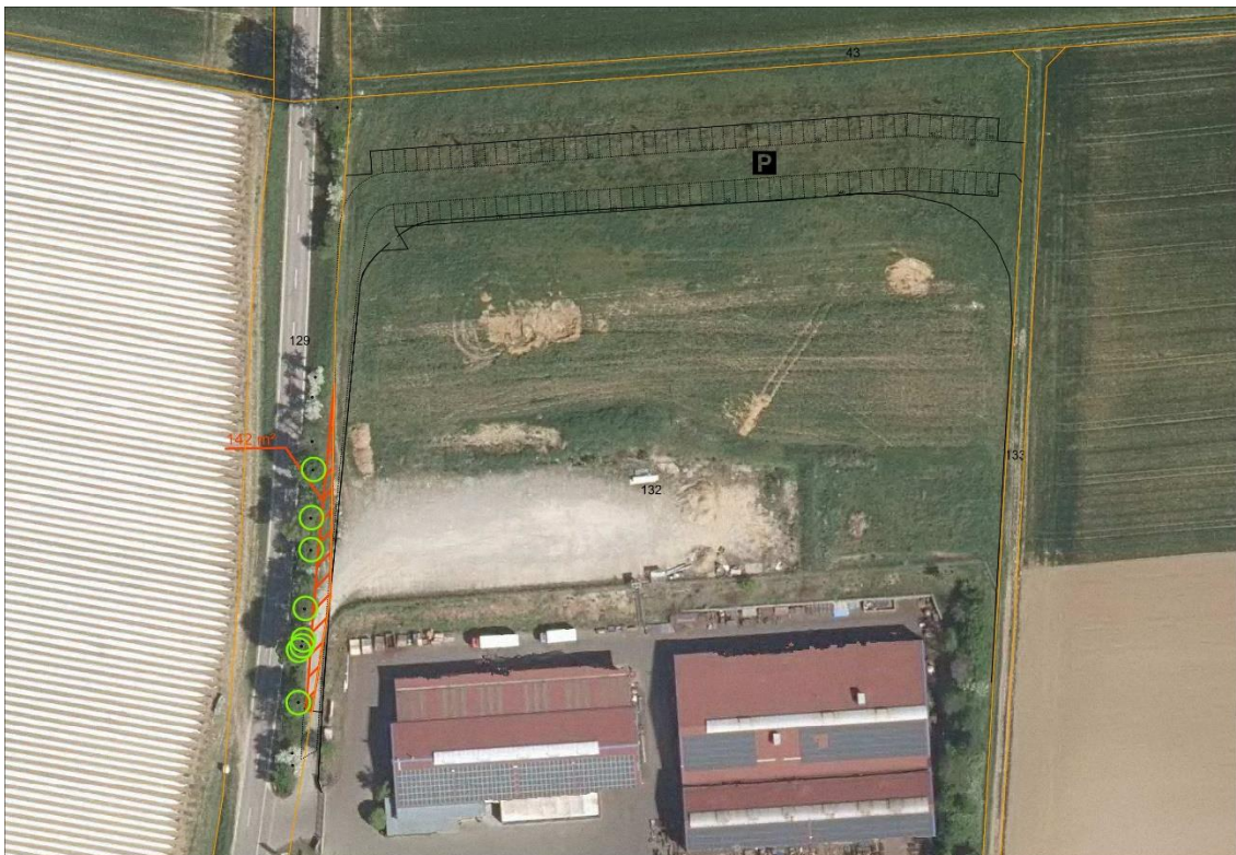
In Anspruch genommene Fläche Flur-Nr. 129 mit Abbildung der entfernten Gehölze entlang der Kreisstraße
